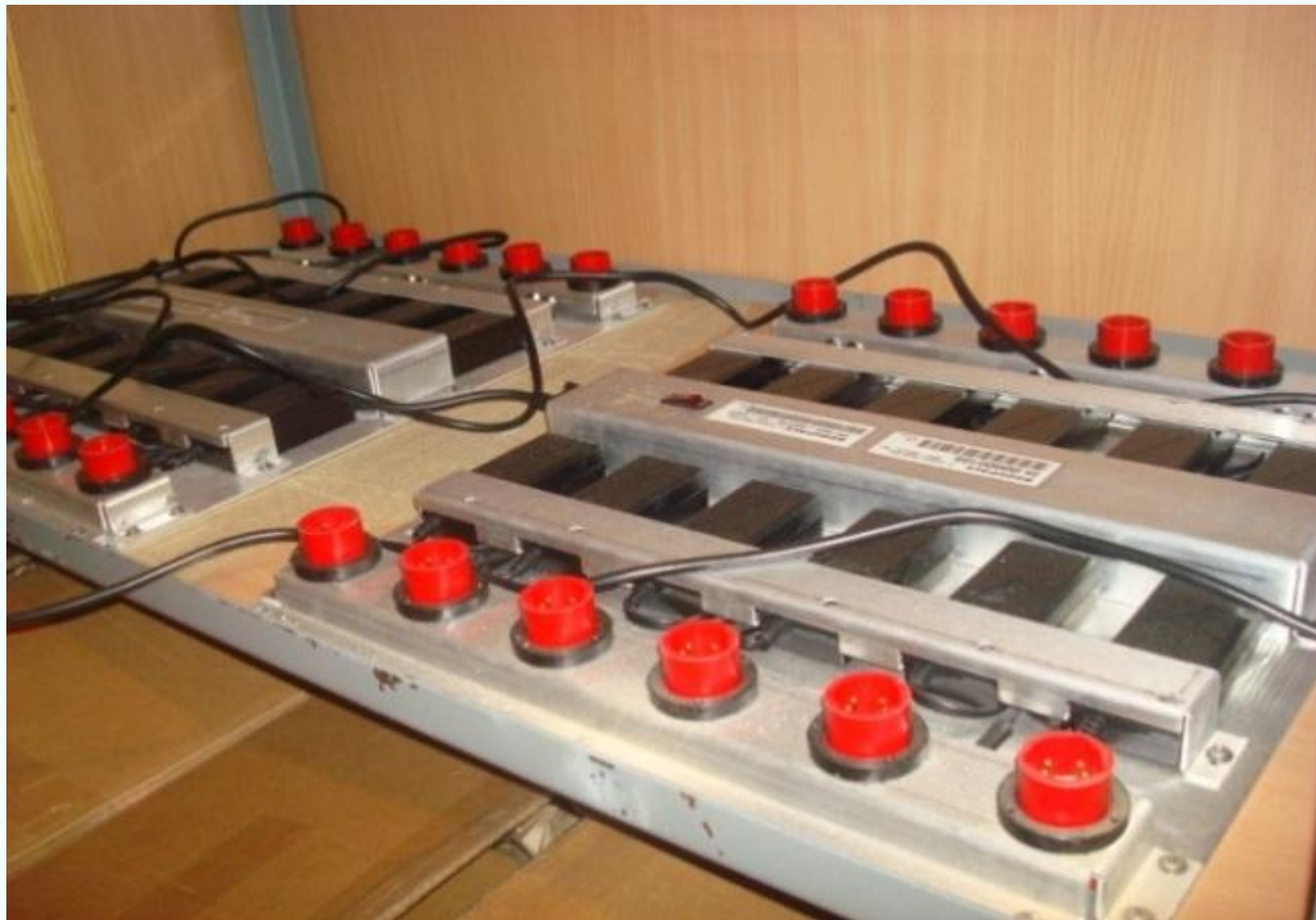
Устройства зарядки аккумуляторов
