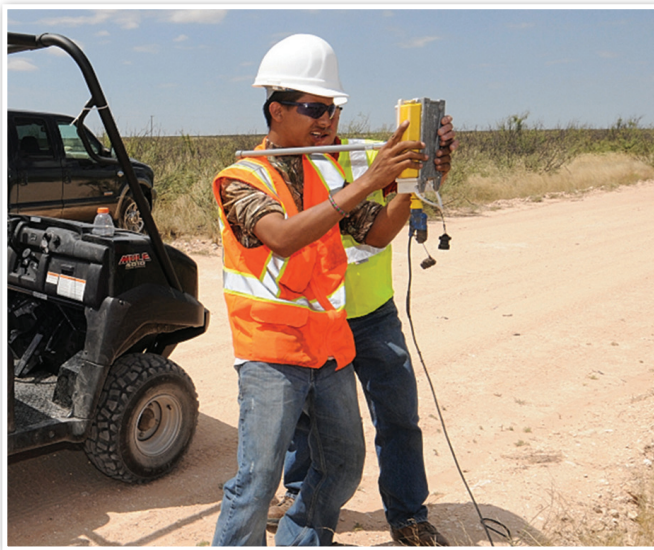
Рис. 2. Конструкция WRU предусматривает быстрое развертывание не имеющими специальными навыками работниками без применения портативных устройств
